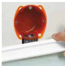
Проверка правильности расположения коробки и мини-каналов
