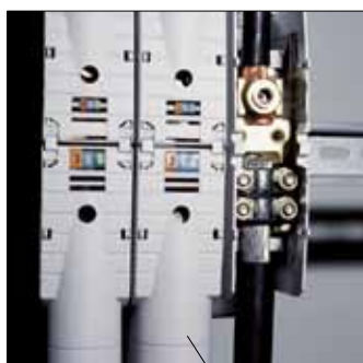
Соединение медных и алюминиевых проводников
