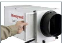
**Accès facile** — Les portes du filtre et le collier de raccordement à la gaine sont libérés par un bouton-poussoir.
