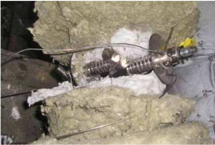
Рис. 1. Двойной запорный клапан компании АС-Шнайдер, установленный на экспериментальном заводе COMTES700 для долгосрочных испытаний конструкции при 700 °С
